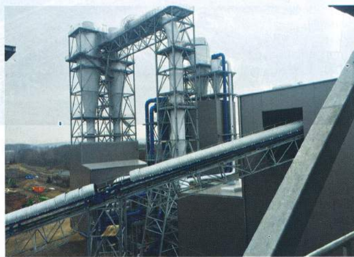
Oben: Blick vom Fasertrockner über die Produktionshalle Unten: Stromrohrtrockner von Büttner in der Ansicht von der Energiezentrale
